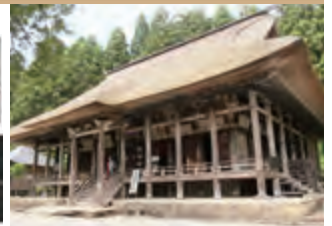
慈恩寺本堂【国指定重要文化財】
